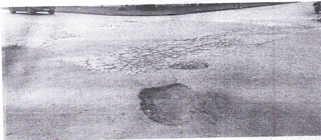
Foto 10 – Rua Tancredo Neves (Santa Rita)
