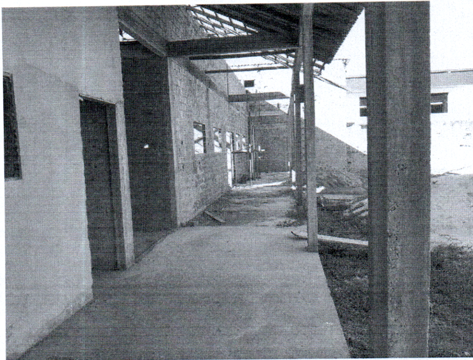
Foto 09 - Salas em construção
