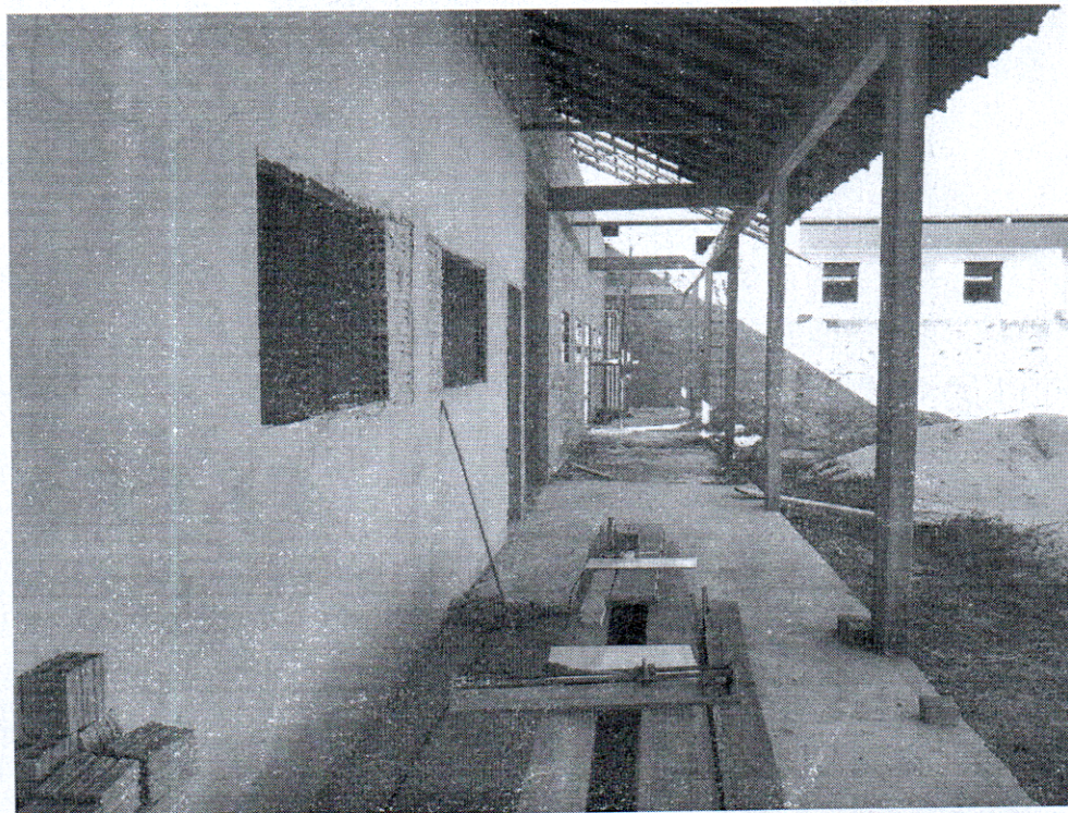
Foto 10 - Salas em construção
