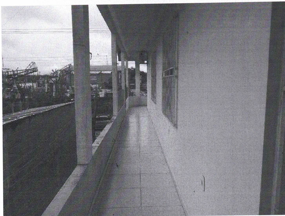
Foto 03 – Corredor, segundo piso.
